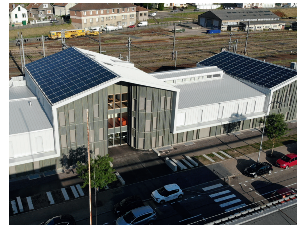
Toiture photovoltaïque de la Maison de l'Habitat et du Territoire - © Terr'EnR
