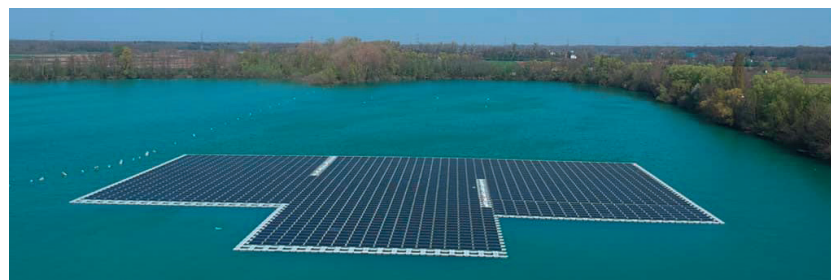
Centrale photovoltaïque flottante - © Ciel & Terre
