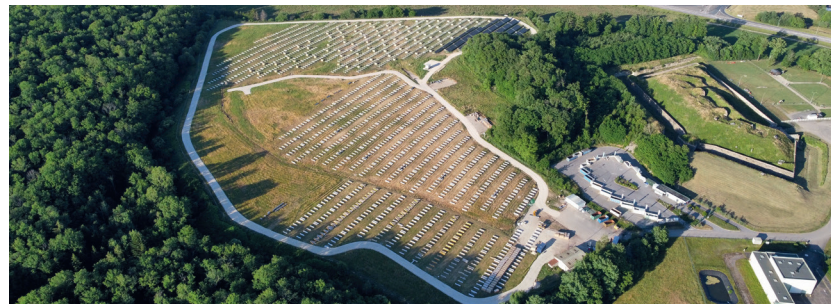
Centrale photovoltaïque en construction - Golbey © Total Energies Renouvelables
